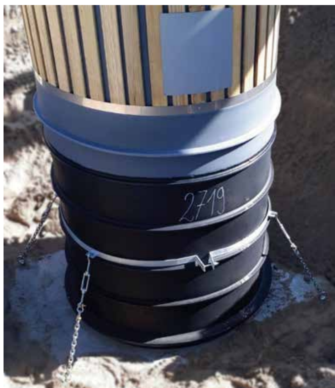
Slika: Postavitev posode v primeru podtalne vode
