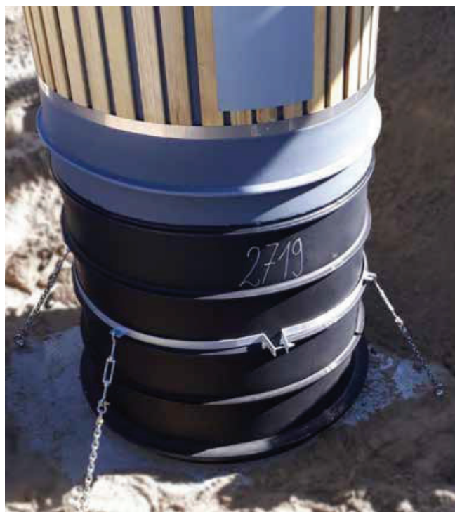
Bild: Behälteraufstellung bei Grundwasser
